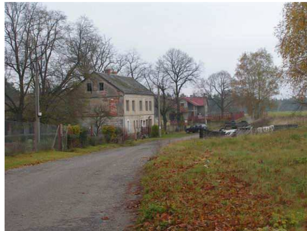
Obr. 5.44: Veselí - stávající dvoupodlažní objekt v osadě.
