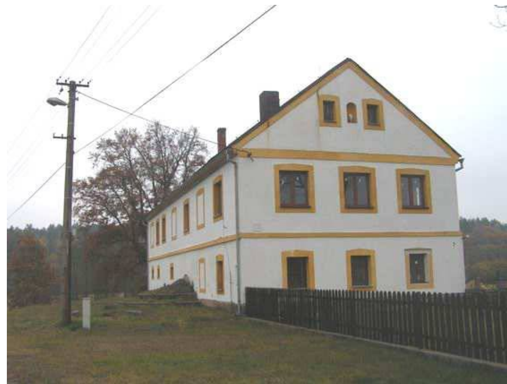
Obr. 5.28: Heřmaničky - zachovalý patrový objekt (jedna z největších staveb v osadě).
