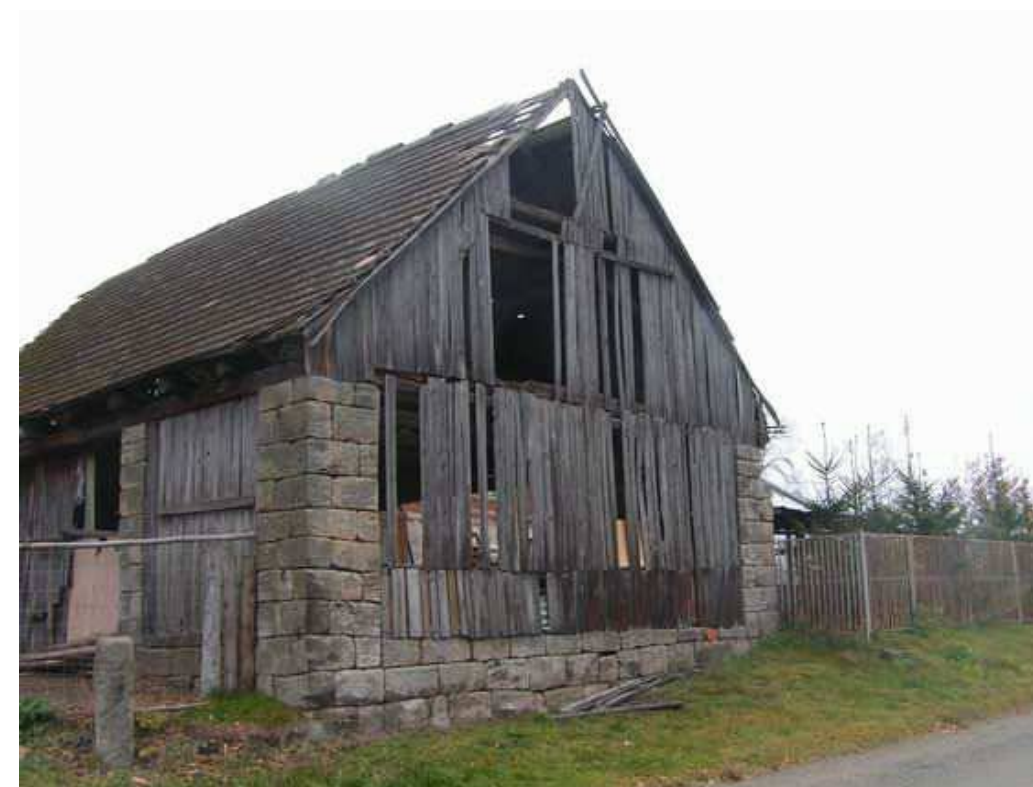
Obr. 5.38: Veselí - stávající objekt.
