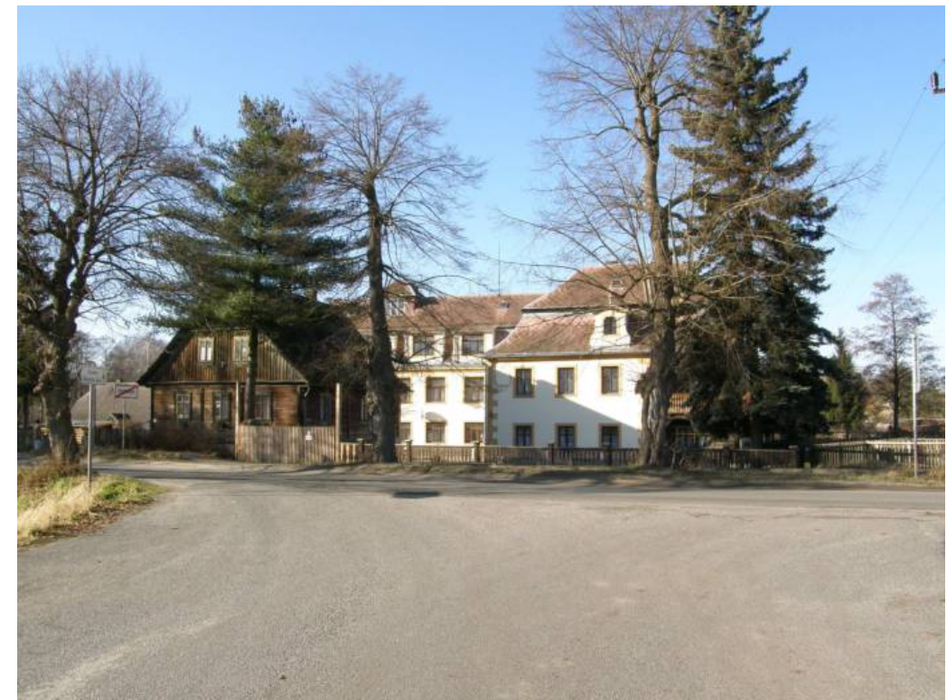
Obr. 5.62: Provodín - (Foto: Atelier V)
