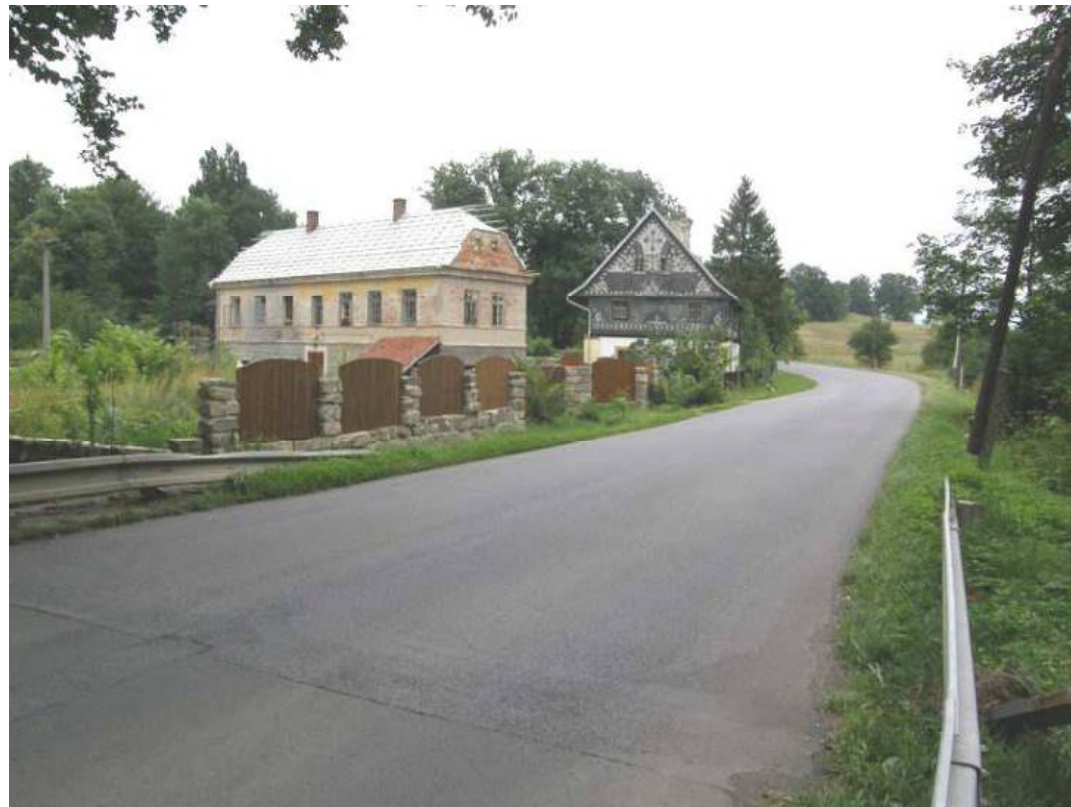
Obr. 5.49: Brenský mlýn - zdobně obložený štít patrového zděného stavení.
