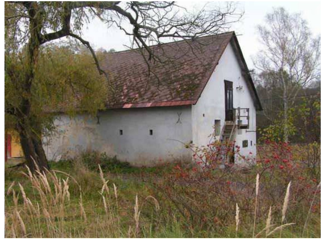
Obr. 5.10: Břehyně - stávající objekt. (Foto: Atelier V)
