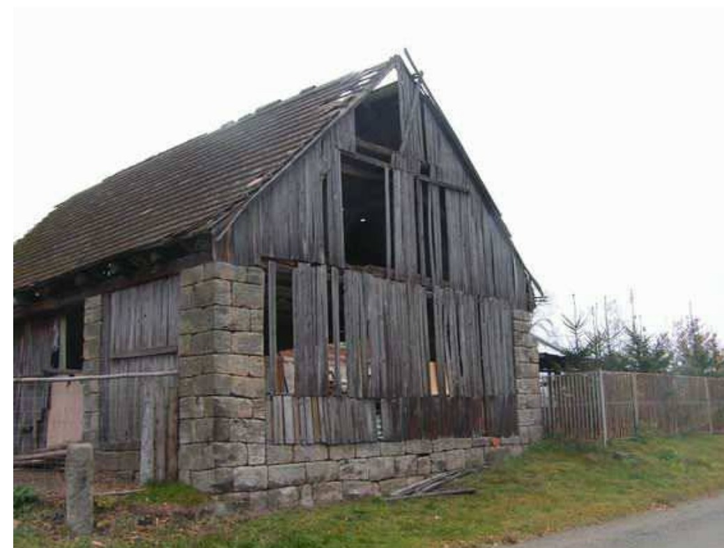
Obr. 5.42: Veselí - stávající objekt.
