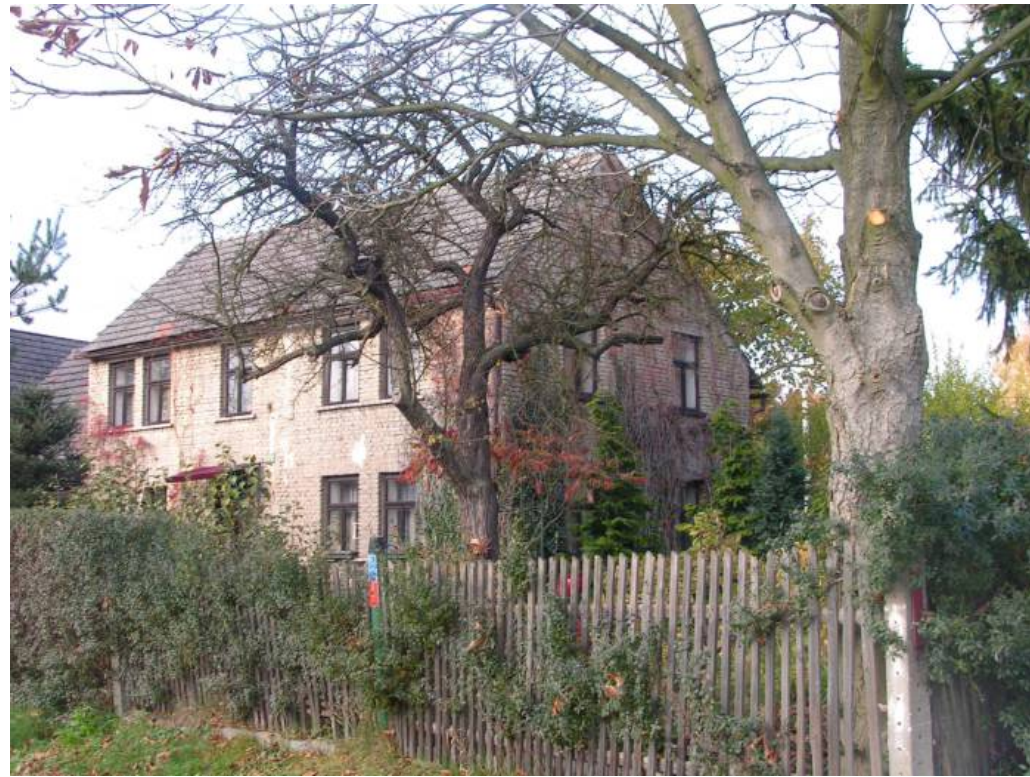
Obr. 5.63: Provodín - (Foto: Atelier V)
