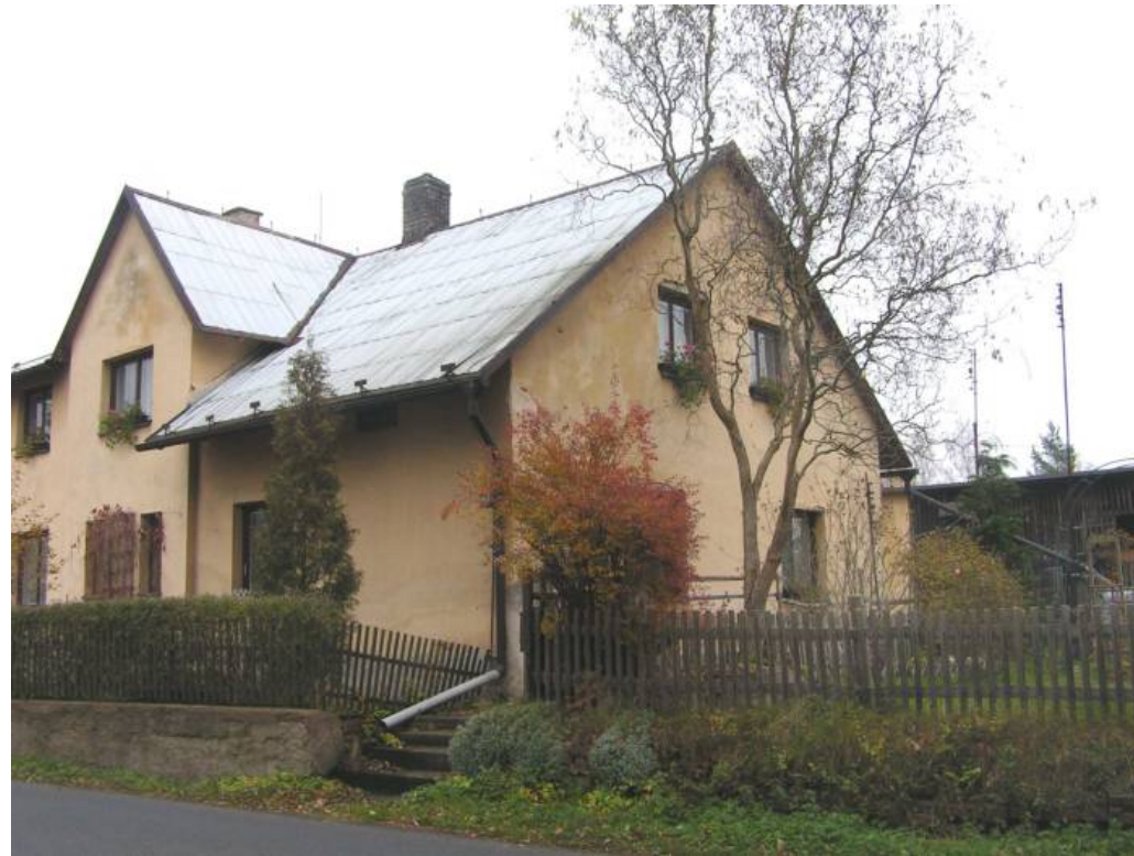
Obr. 5.75: Hradčany – (Foto: Atelier V)
