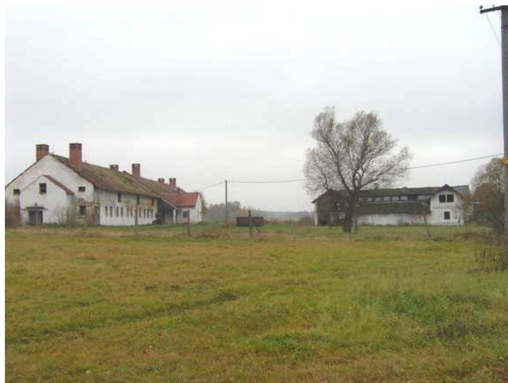
Obr. 5.27: Heřmaničky - polorozpadlý zemědělský areál na okraji osady.
