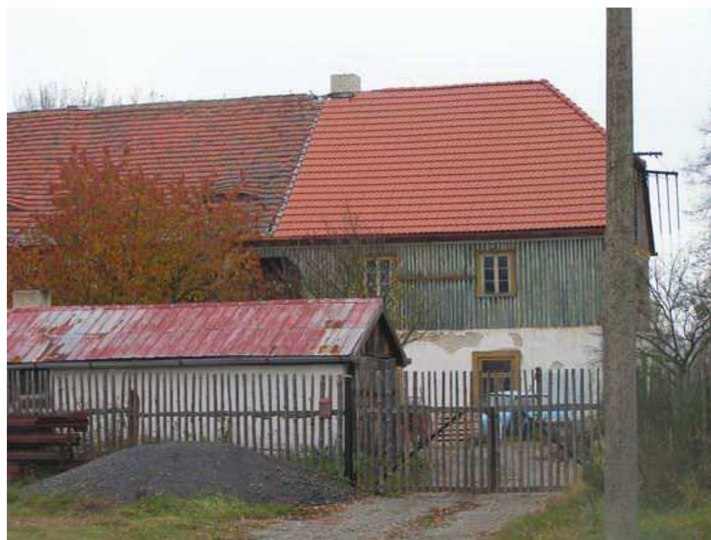
Obr. 5.37: Veselí - dvoupodlažní objekt.
