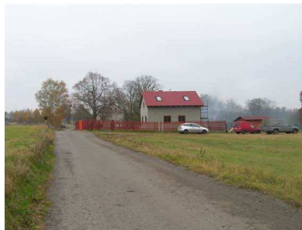
Obr. 5.46: Veselí - novodobé objekty při příjezdu do osady od východu.
