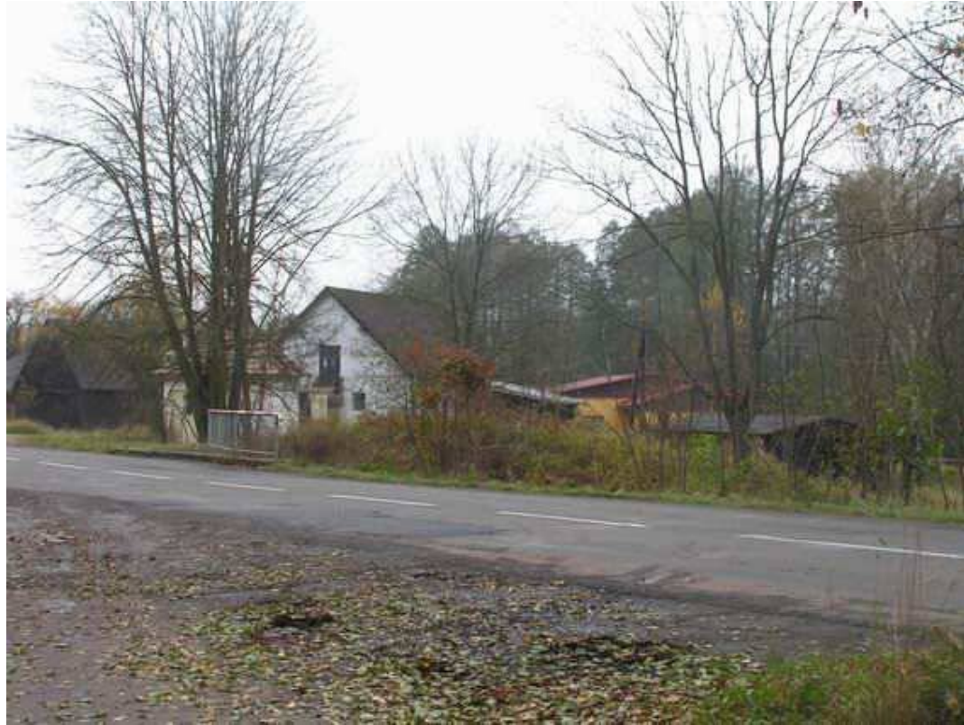
Obr. 5.9: Břehyně - stávající objekty. (Foto: Atelier V)
