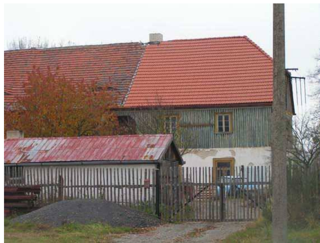
Obr. 5.41: Veselí - dvoupodlažní objekt.
