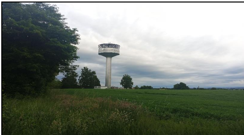
Obr. 7: Věžový vodojem v Suchdole nad Lužnicí. (Foto: ekologievpraxi.cz, 2025)
