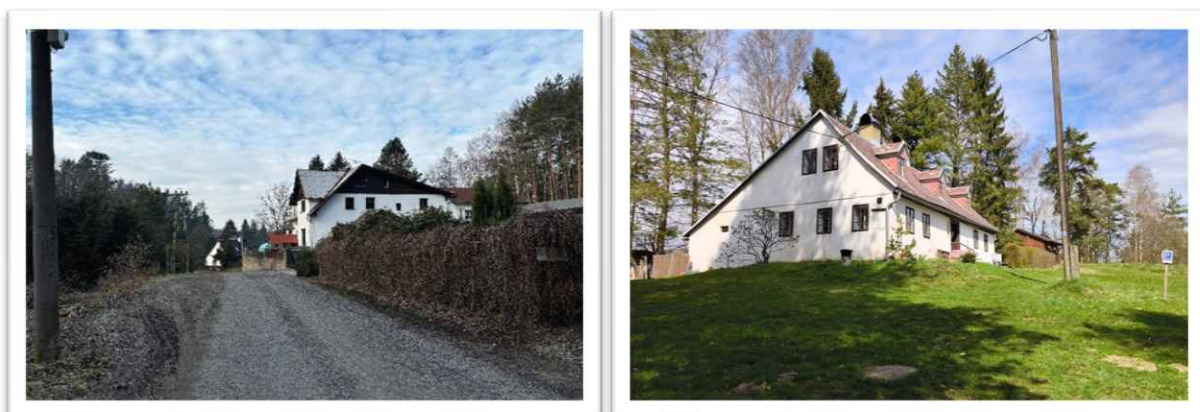
Foto 14 a 15: Zástavba podél místní komunikace, zděná chalupa většího měřítka
