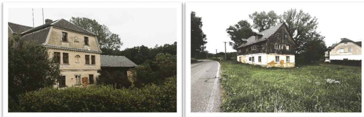
Foto 25 a 26: Patrový zděný dům s kolmou stodolou, dům č. 358 je ve špatném technickém stavu
