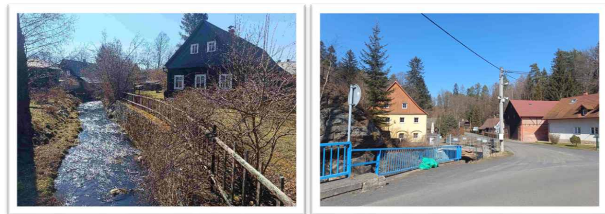
Foto 171 a 172: Zástavba je rozptýlená podél Chřibské Kamenice, Penzion U Vyhlídky na rozcestí
