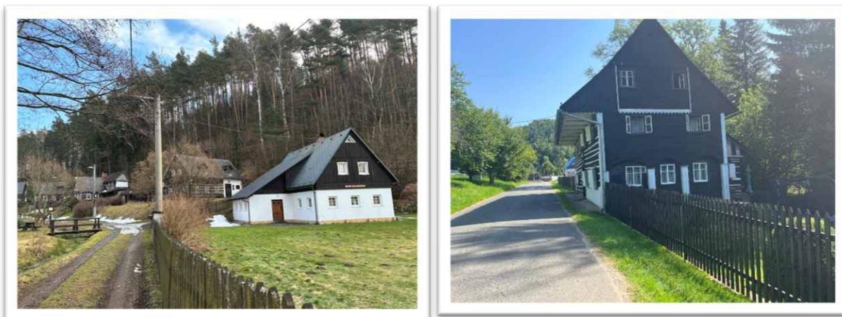
Foto 52 a 53: Liniová zástavba pod Kalvárií, vícepodlažní dům č. p. 137
