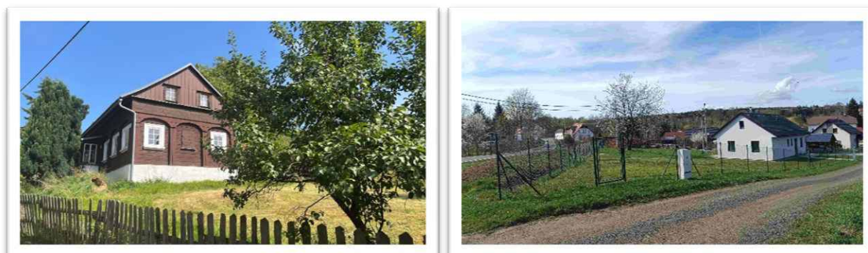
Foto 201 a 202: Podstávkový dům a novostavby na okraji obce s tradičním měřítkem
