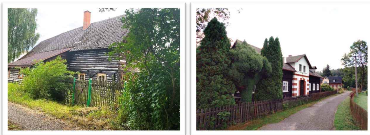
Foto 21 a 22: Hrázděný dům v sídle Lada v Podještědí, dům č. p. 29 je tradičního měřítka
