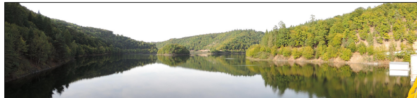
obr. č. B.18: Vodní nádrž Klíčava v pohledu z hráze
