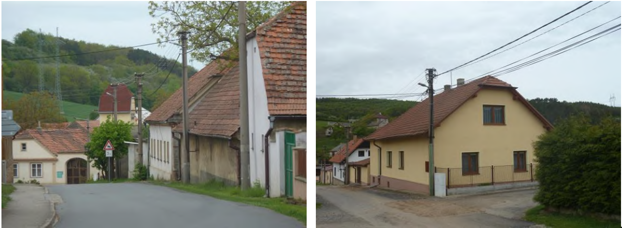
Obr. 2.2.191a, 2.2.191b: Typická zástavba obce.
