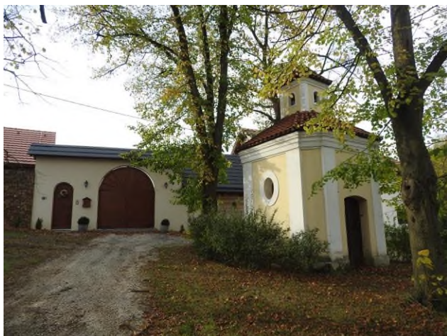
Obr. 2.2.198: Kaple před renovovanou vjezdovou branou.
