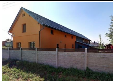
Modernizace jiné usedlosti, nevhodně upravená fasáda a oplocení
