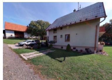
Typická dostavba rodinného domu pod hospodářskou budovu do volného prostoru u zemědělského dvora
