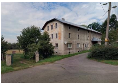
Objekt mlýna, stavba má vysoký potenciál rekonstrukce v historické podobě
