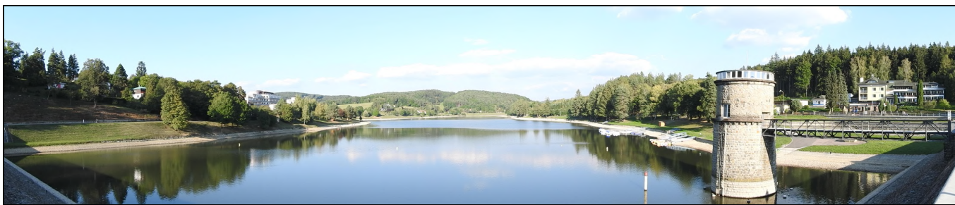
obr. ř. B. 24: Vodní nádrĤ Luhal'ovice v pohledu z hráze
