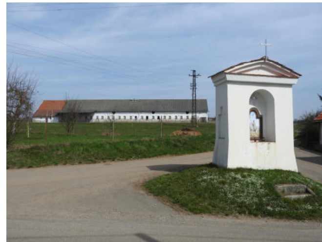
obr. č. C.64: Jeden z celkem zdařilých příkladů obnovy venkovského stavení v původní zástavbě ve východní části sídla; vhodně byla zvýrazněna lineární průběžná zed'
