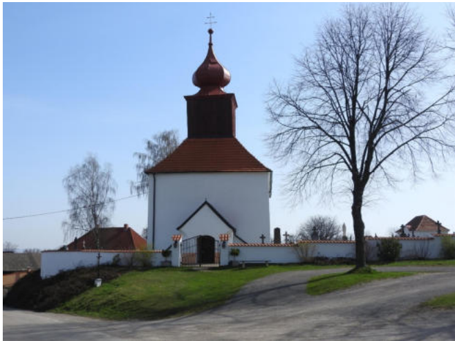
obr. č. C.126: Výklenková kaplička v horní části návsi; umístění zastávky a mobiliáře v těsné blízkosti nepůsobí zcela harmonicky
