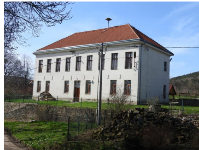
obr. č. C.43: Hospodářský objekt ve východní části sídla s valbovou i sedlovou konstrukcí střechy; žádoucí se jeví výsadby před přístupovou cestou
