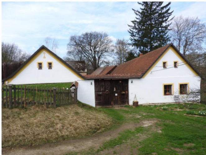
obr. č. C.81: Prostřední usedlost jednoduchého uspořádání; zdařilého výrazu bylo dosaženo i díky kvalitní obnově
