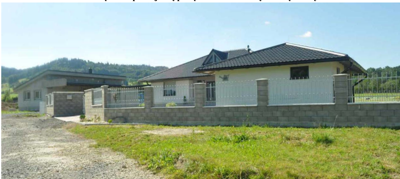
Obrázek 16: Příklad stavby nerespektující typický charakter beskydské výstavby
